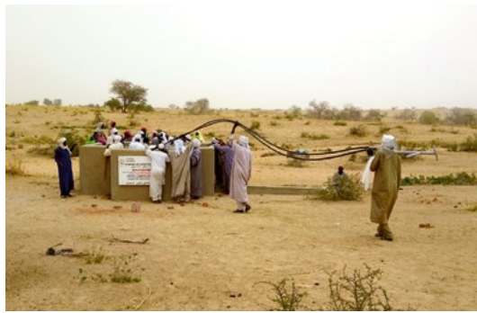
Die Installation einer Wasserpumpe setzt grosses Geschick voraus.
