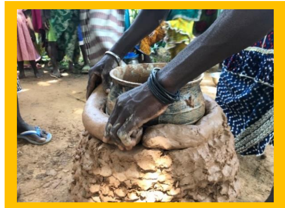
Bau einer holzsparenden Kochstelle
