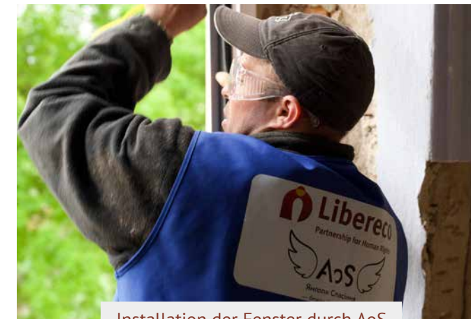
Installation der Fenster durch AoS
