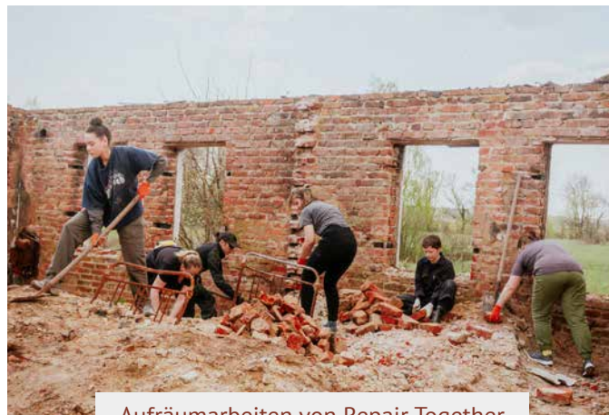
Aufräumarbeiten von Repair Together
