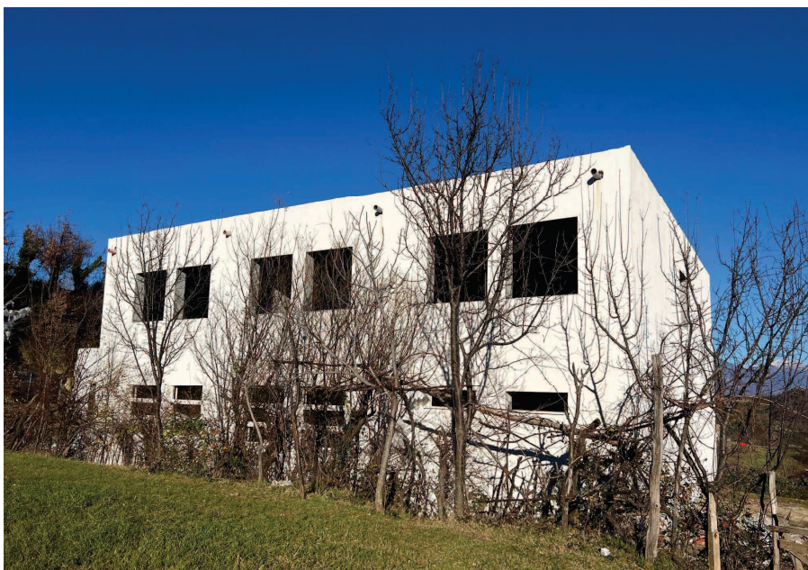
Grossprojekt in Frankth, Albanien: eine 9-Jahresschule im Bau
