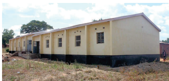
Das Praxisgebäude der Berufsschule in Ezondweni (Malawi) musste lange auf den Stromanschluss warten
