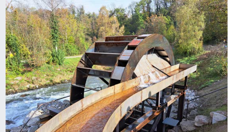
L'eau coule pour la première fois dans le nouveau canal d'amenée
