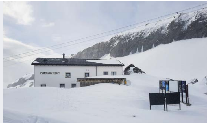
La Segneshütte (GR) lors de l’inspection locale en février 2022
