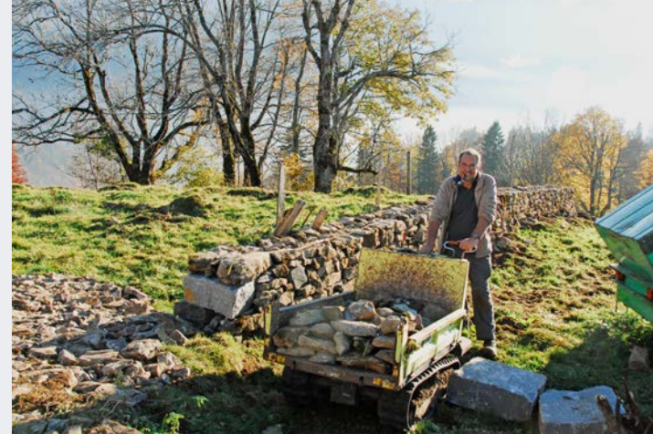
Travaux de remise en état d'un mur de pierres sèches à Illgau (SZ)
