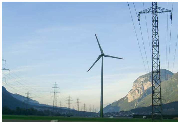
Windkraftanlage in Collonges VS nahe der Stromleitung
